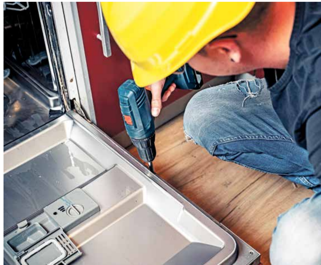
Handwerker bei Spülmaschinenreparatur: Reparatur zu „einem angemessenen Preis“?
